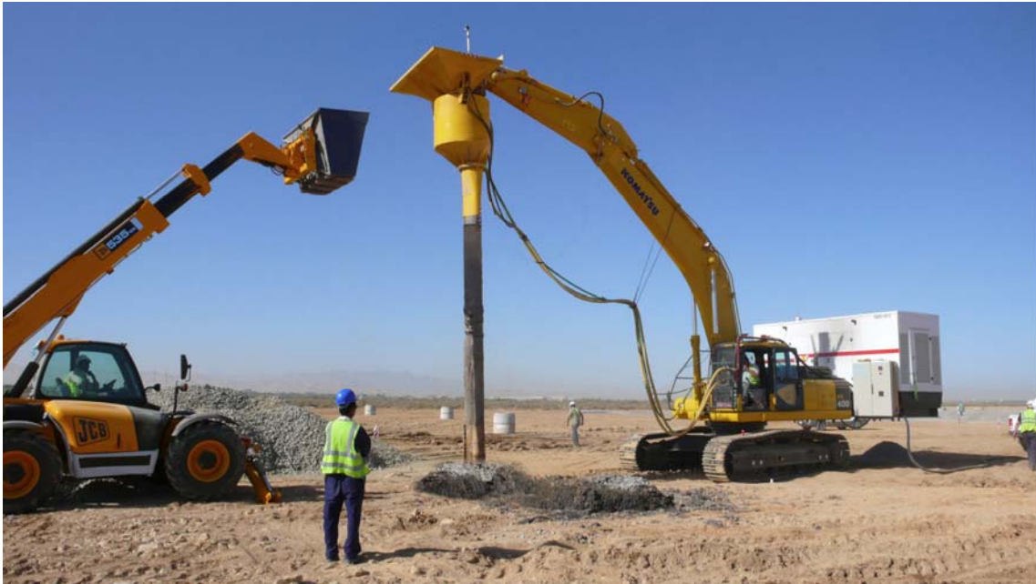
BL3 Equipo de Columnas de Grava, montado en mástil para excavadora o maquina base.
